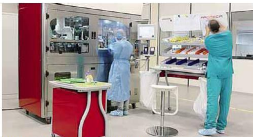
L'impianto robotizzato installato all'ospedale «Pesenti Fenaroli» di Alzano
