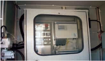
Fotoğraf: Sürekli ölçüm cihazlarından veri alınması
